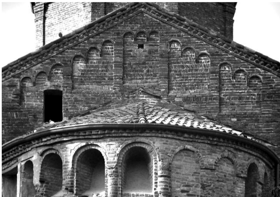
Abside della Chiesa di San Giorgio (foto di Mattia Freddi)
